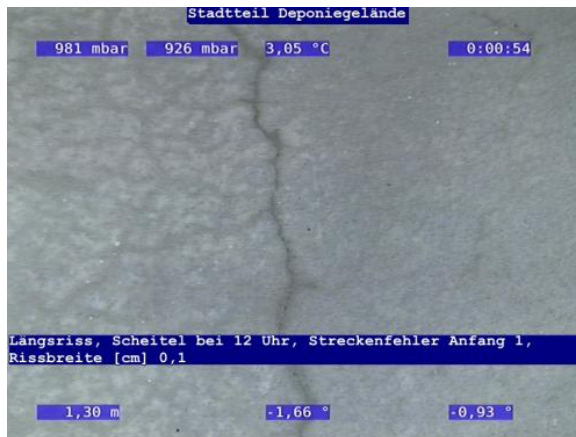
Abbildung 24: Längsriss bei 1,3 m
