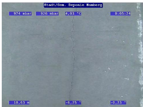
Abbildung 21: Längsriss bei 18,63 m
