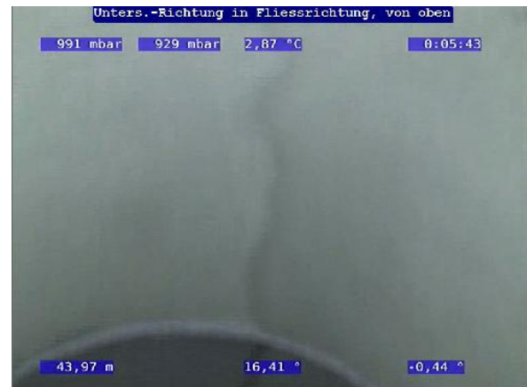
Abbildung 25: Längsriss bei 43,7 m
