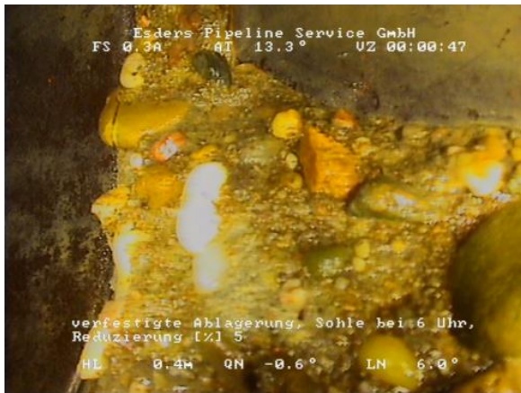
Abbildung 13: verfestigte Ablagerung S81 - S82
