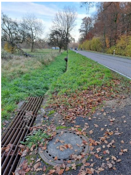
Abbildung 32: Übersicht Berststrecke Richtung Deponie- gelände
