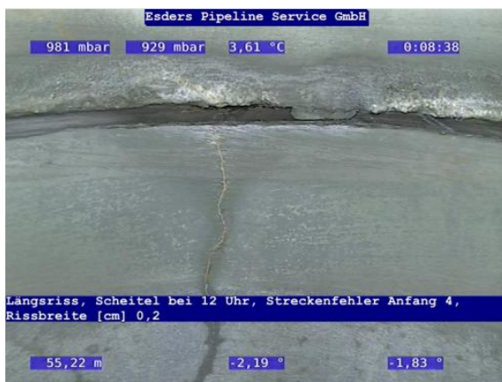
Abbildung 23: Längsriss bei 55,22 m
