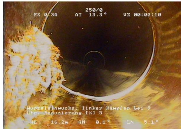
Abbildung 14: Wurzeleinwuchs linker Kämpfe S81 - S82
