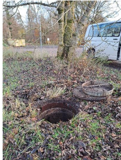
Abbildung 27: Schacht S73 (Zielgrube 1)
