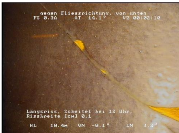
Abbildung 15: Längsriss S83 - S84
