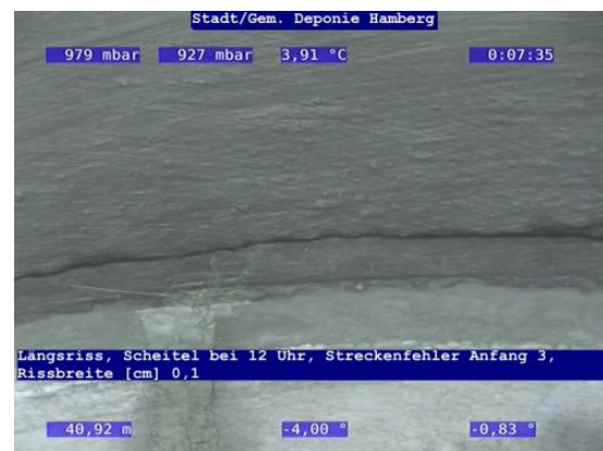
Abbildung 22: Längsriss bei 40,92 m
