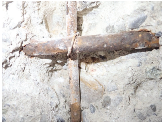
Bild 3009 – geöffnete Prüfstelle
